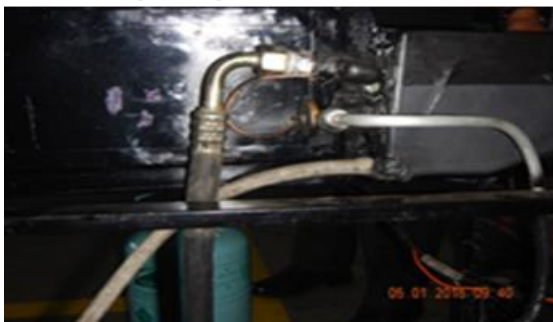
Gambar 7. Katup ekspansi
