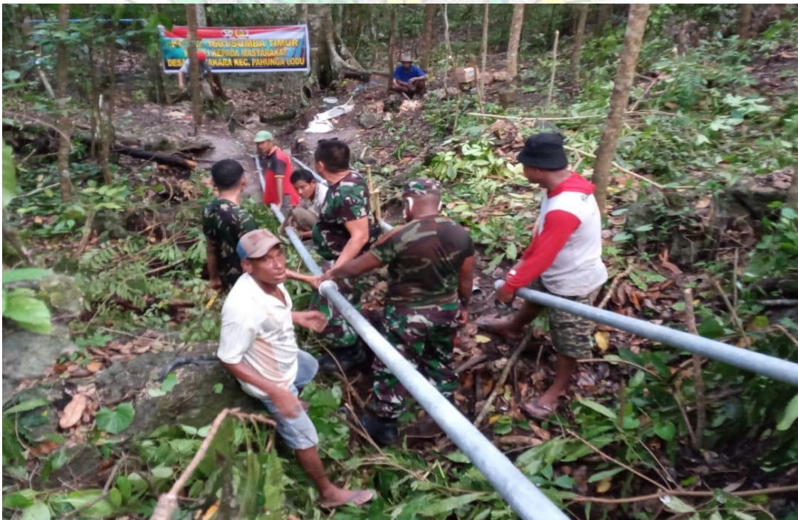
Gambar.4 Pemasangan pipa yang telah diukur Pengabdi dan masyarakat
