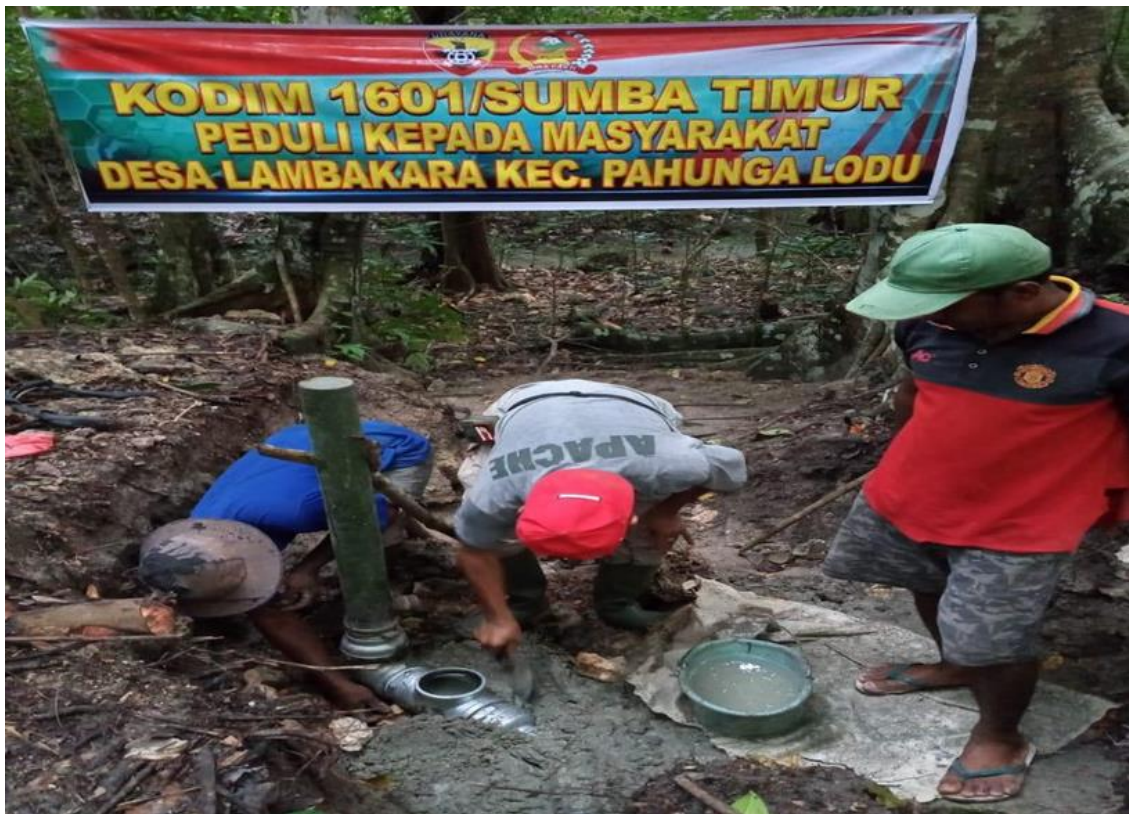
Gambar.6 Kegiatan pemasangan tabung pompa sebelum dipasang rangkaian pompa.
