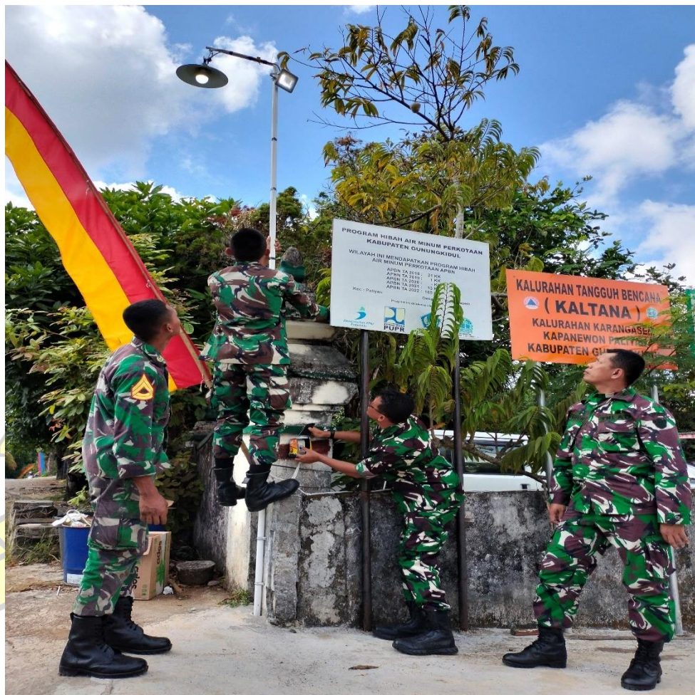
Gambar 2 Pemasangan instalansi listrik dan lampu
