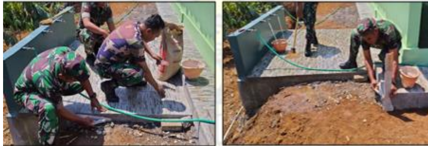
Gambar 8. Pelaksanaan Perbaikan Lantai Keramik Pos Pengamanan (Data Primer PKM Prodi Nik Sipil Han, 2022)
