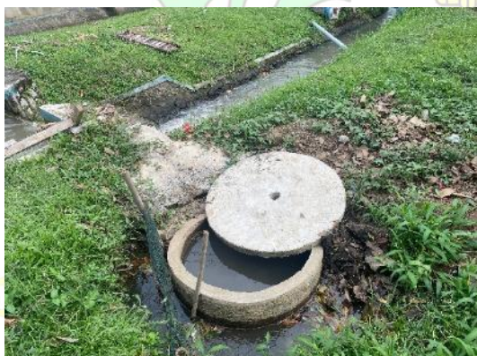
Aktualisasi Pemasangan Bak Penyaringan
