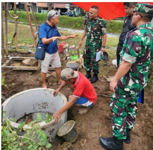
Pekerjaan Pemasangan Buis Beton
