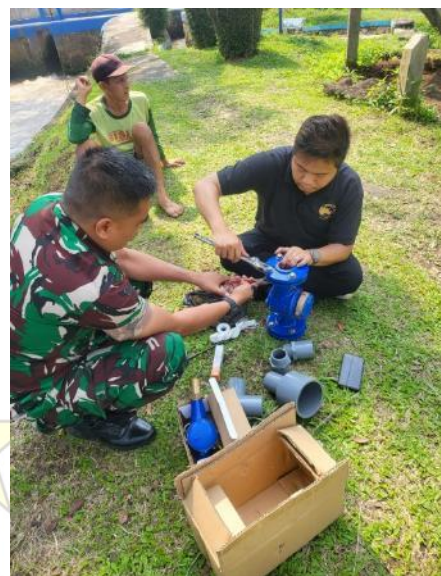
Pekerjaan Pemasangan Pompa
