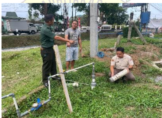
Aktualisasi Pemasangan Pipa Aktualisasi Pemasangan Papan Informasi
