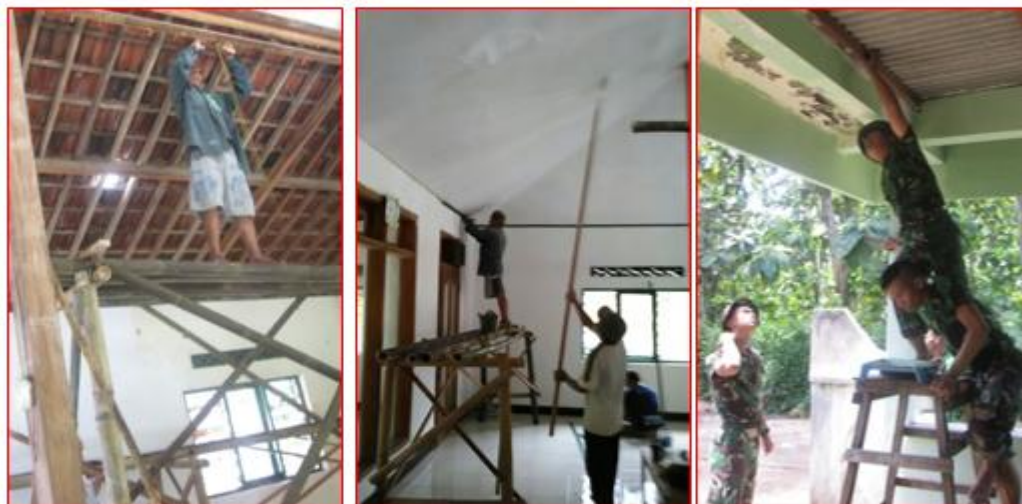
Gambar 3,4,5. Memasang rangka kayu dan penutup plafond dengan tripleks serta pengecatan plafond utama dan teras Masjid Nurul Huda Desa Bendo Kec.Nogosari Kab. Boyolali
