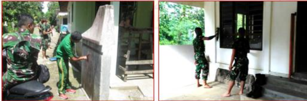
Gambar 1,2. Pembersihan dinding dan kusen jendela/pintu di Masjid Nurul Huda Desa Bendo Kec.Nogosari Kab. Boyolali
