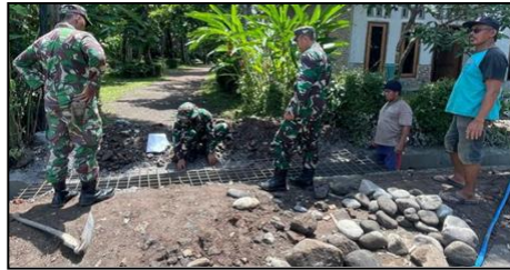
Pekerjaan Perbaikan Drainase Jalan
