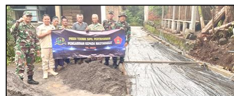
Hasil Perbaikan Badan Jalan
