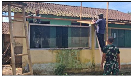
Pekerjaan Perbaikan Bangunan TPA
