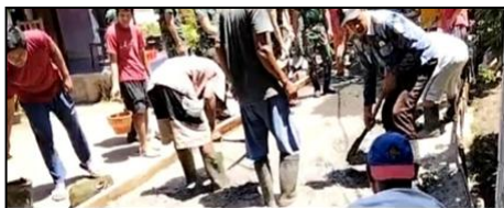
Pekerjaan Perbaikan Badan Jalan
