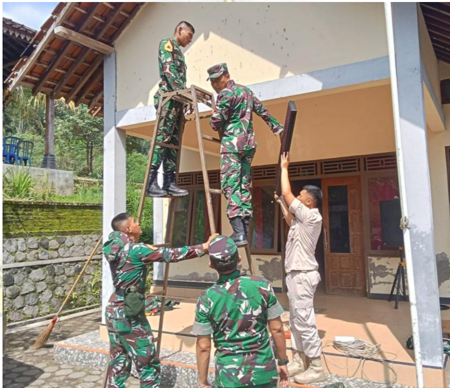
Gambar 3 Proses Pemasangan Runing Text di Balai Desa Kenalan Borobudur Magelang.
