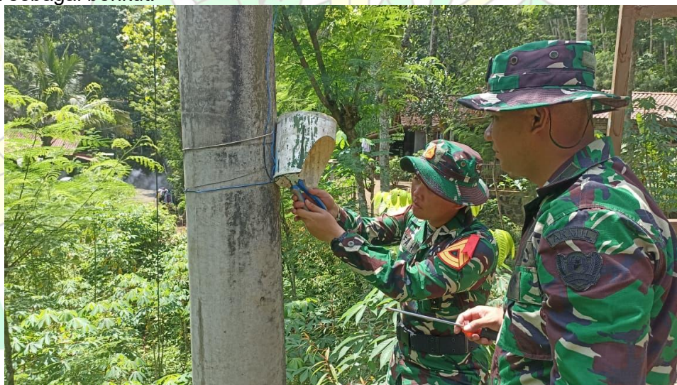
Gambar 2 Proses Pengujian dan Kalibrasi Instalasi Penerangan
