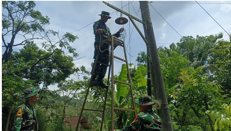
Gambar 1 Proses Perakitan Instalasi Penerangan Indoor dan Outdoor di Balai Desa Kenalan
