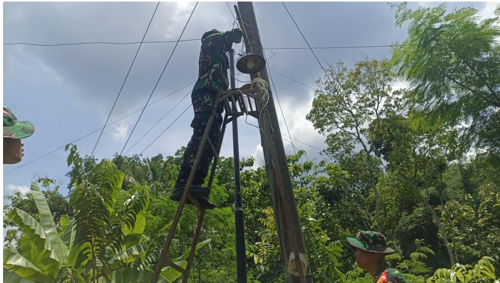
Gambar 3 Proses Pemasangan Instalasi Penerangan di Balai Desa Kenalan Borobudur Magelang
