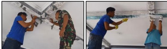
Gambar 15. Proses Injeksi dan Pemasangan FRP StrongGlass E450 (Sumber: Kristanto dkk, 2023)
