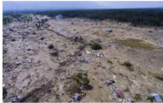
Gambar 4. Dampak Liquefaksi Yang Terjadi Pada Desain Geometrik Jalan Di Area Jonooge Akibat Gempa Palu 2018 menggunakan Drone berbasis SIG
