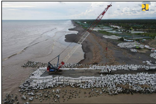
Gambar 2. Proses pembangunan Infrastruktur pengendali banjir Bandara Yogyakarta Internasional Airport (YIA) (Sumber: kompas.com, 2022)
