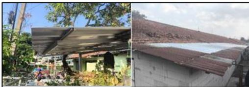
**Gambar 3.** Perbaikan Atap rumah yang Rusak dengan Material yang Berbeda (Sumber: Penulis, 2024)
