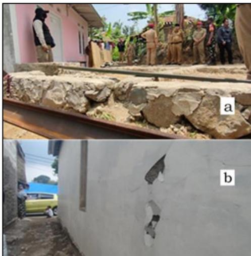
**Gambar 7.** (a) Pondasi RTG Mangkrak (Selamet, 2023); (b) Kerusakan pada Muka Dinding Luar RTG (Antara, 2023)
