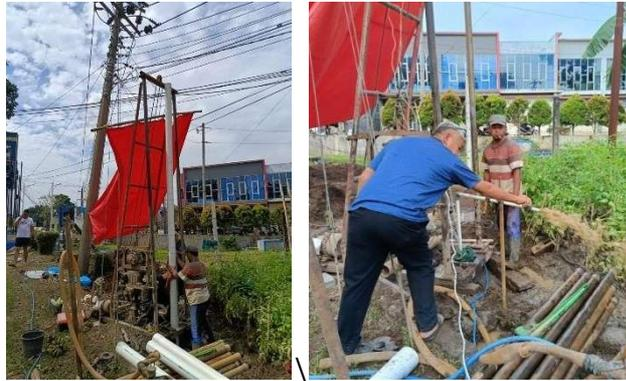
**Gambar 7.** Pembuatan Sumur Bor
