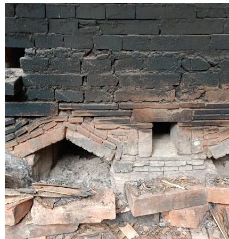
Gambar 7. Susunan batu bata dalam tungku pembakaran di Mertoyudan (Sumber: Dokumentasi peneliti, 2025)
