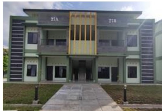
Gambar 2. Gedung Paviliun Baru setelah direnovasi. (Sumber: Data Primer, 2023)
